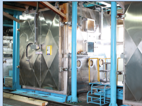
Вакуумная пропитка обмоток
